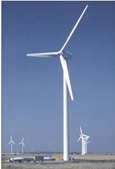
Figura 13 - Aerogerador de eixo horizontal
