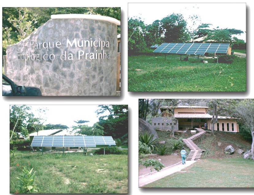
Figura 2 – sistema fotovoltaico isolado do prédio sede do PNM Prainha
