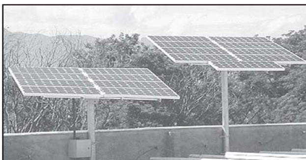
Figura 4 - Estrutura de fixação no telhado.
