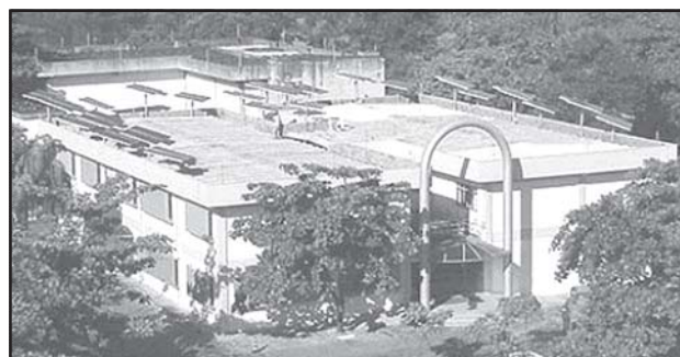
Figura 5 - Vista geral da instalação.
