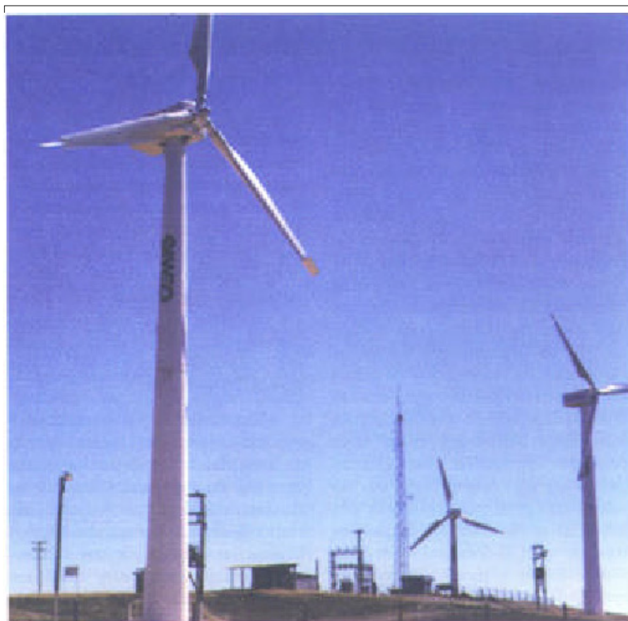
Foto 1: Fazenda Eólica de 1MW, da CEMIG, no Morro do Camelinho
