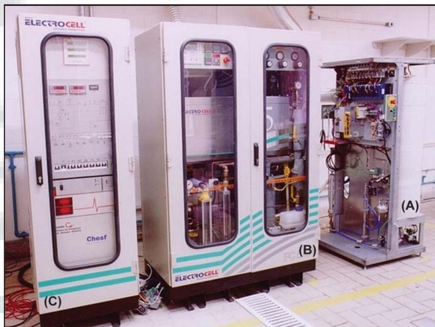
Sistema de CaC de membrana polimérica trocadora de prótons instalada no Laboratório do CEPEL: (A) Reformador de GN; (B) Unidade PEMFC; (C) Sistema de eletrônica de potência (inversor) e banco de baterias.
