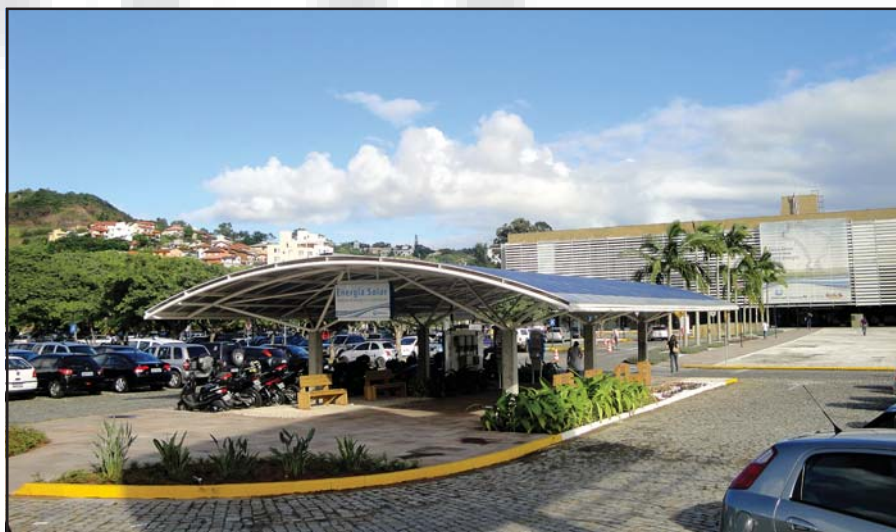
Planta piloto de geração fotovoltaica instalada desde fevereiro/2009.
