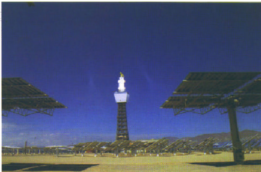
Esta planta, Solar Two, com campo de heliostatos e torre central está sendo inaugurada no dia 5 deste mês
