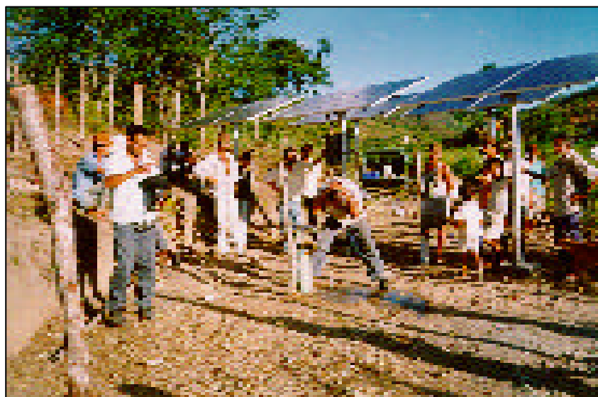
Instalação do poço artesiano em Macacos
