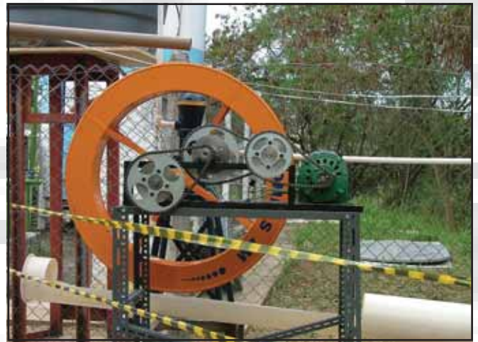
Roda d'água instalada no Centro de Energias Renováveis da UNESP - Campus Guaratinguetá.
