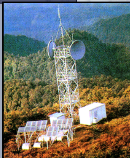
Estações repetidoras de micro-ondas, rádio VHF/UHF ou TV
