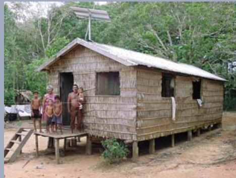
Sistema Fotovoltaico N.S.P. Socorro - Manacapuru
