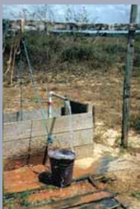
Abastecimento comunitário de água da comunidade de Amapá Grande Município de Amapá - AMAPÁ
