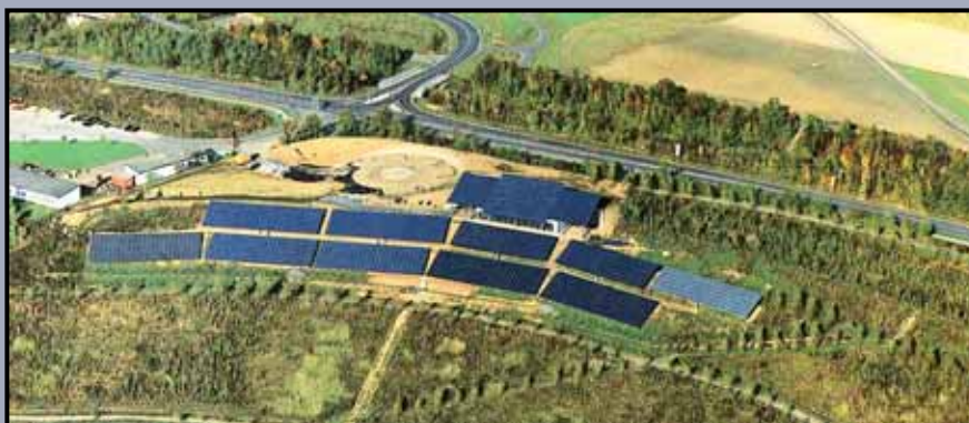
Central Fotovoltaica Neurather See (Alemanha) 360kWp
