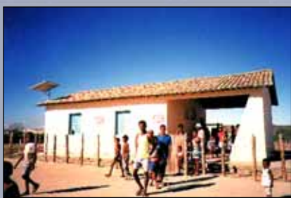
Escola da comunidade de Baixão do Archanjo Município de Barra
