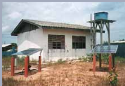
Sistema energético no posto de saúde e bombeamento da comunidade de Lago Novo Município de Tartarugalzinho - AMAPÁ
