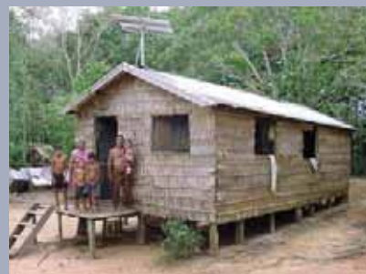
Sistema Fotovoltaico N.S.P. Socorro - Manacapurú
