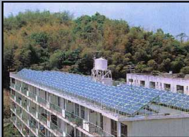
Sistema fotovoltaico sobre o telhado de um condomínio residencial - Japão
