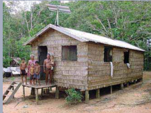
Sistema solar fotovoltaico instalado em N.S.P. Socorro – Manacapuru
