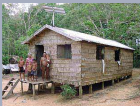
Sistema Fotovoltaico N.S.P. Socorro - Manacapuru
