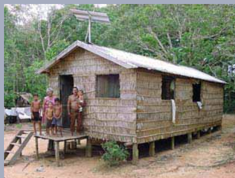
Sistema Fotovoltaico N.S.P. Socorro - Manacapuru
