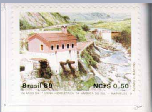
Usina Hidroelétrica Marmelos Zero – MG - 1889
