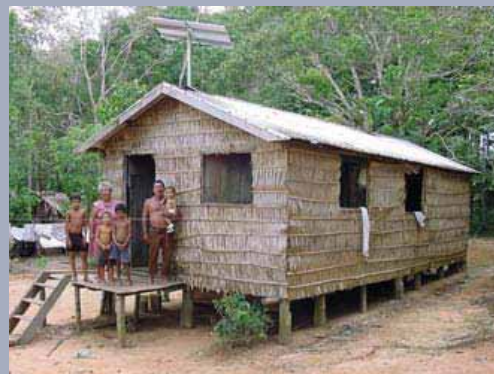
Sistema solar fotovoltaico instalado em N.S.P. Socorro – Manacapurú
