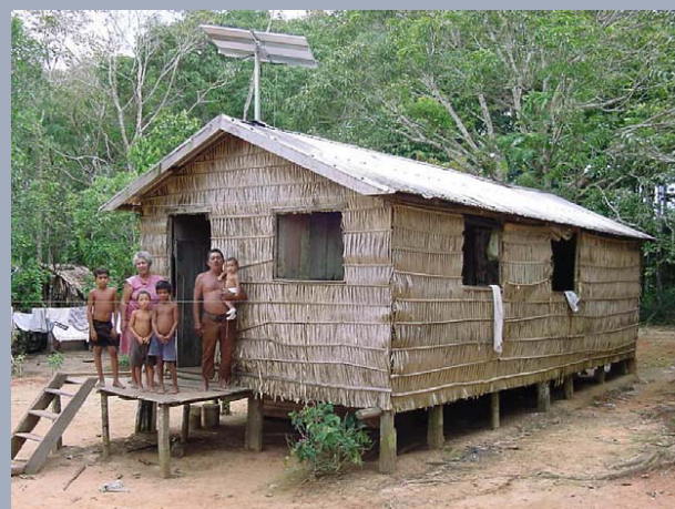
Sistema Fotovoltaico N.S.P. Socorro - Manacapuru
