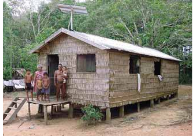
Sistema solar fotovoltaico instalado em N.S.P. Socorro – Manacapuru
