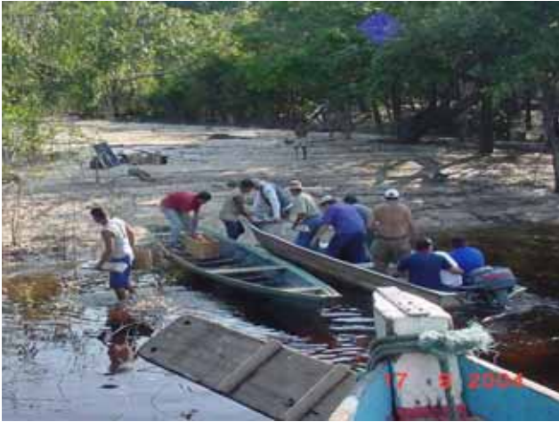
Transporte dos equipamentos fotovoltaicos
