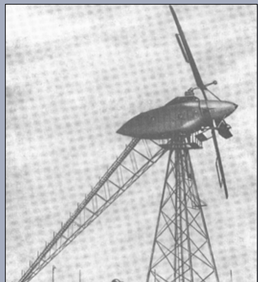
Turbina Eólica Balaclava (1931) – 100 kW
