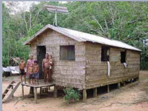
Sistema Fotovoltaico N.S.P. Socorro - Manacapuru
