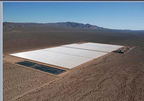
Nevada Solar One, 64 MW (construção).
