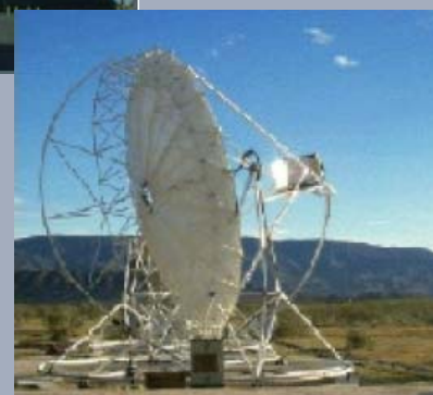
Duas concepção de discos parabólicos com potência nominal de 10 kW
