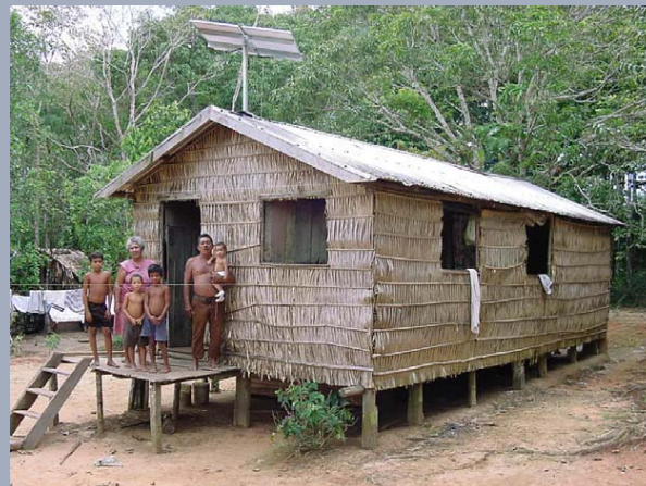
Sistema Fotovoltaico N.S.P. Socorro - Manacapuru
