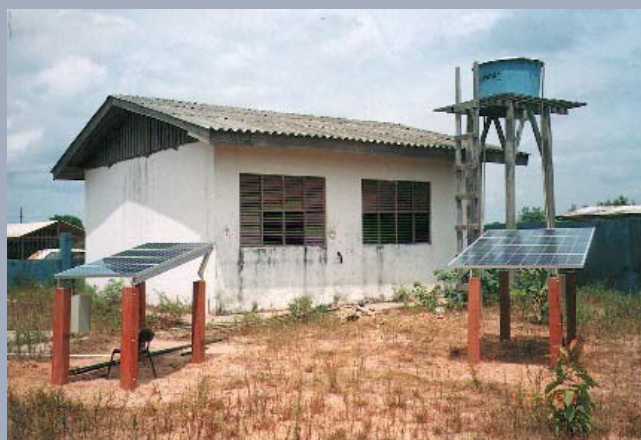
Sistema energético no posto de saúde e bombeamento da comunidade de Lago Novo Município de Tartarugalzinho - AMAPÁ
