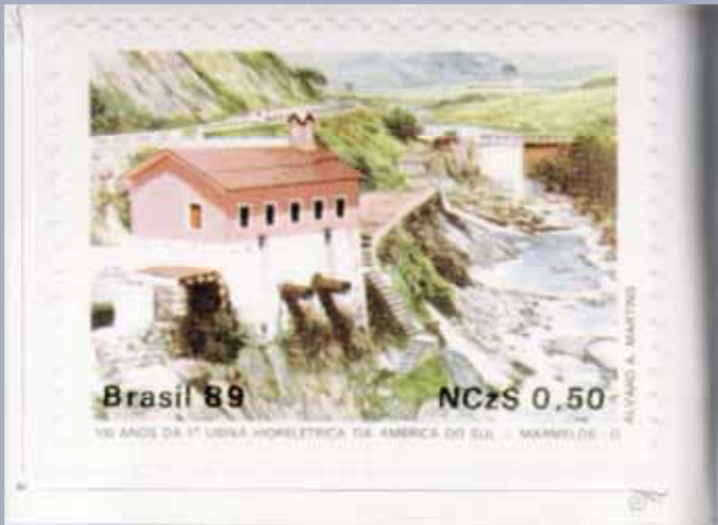
Usina Hidroelétrica Marmelos Zero – MG - 1889
