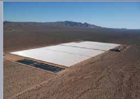
Nevada Solar One, 64 MW (construção).
