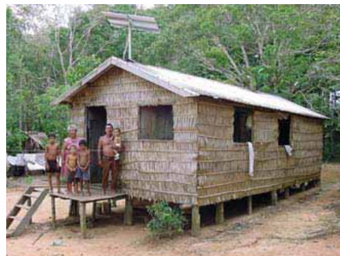
Sistema instalado em N.S.P. Socorro – Manacapurú
