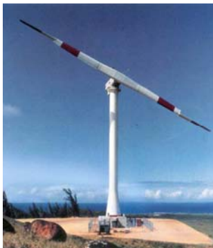
Turbina MOD-5B (1987 – 1993) Estados Unidos - 3.5 MW
