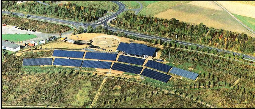
Central Fotovoltaica Neurather See (Alemanha) 360kWp
