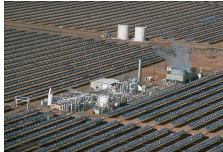
Solar Electric Generation Station – SEGS 354 MW (9 unidades), Deserto de Mojave, USA 0,65 km 2 /100MW, 2300 a 2900 kWh/m 2 .ano
