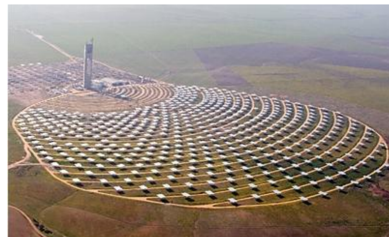
Planta PS10 (11 MW, com armazenagem de energia), Espanha, Sevilla.
