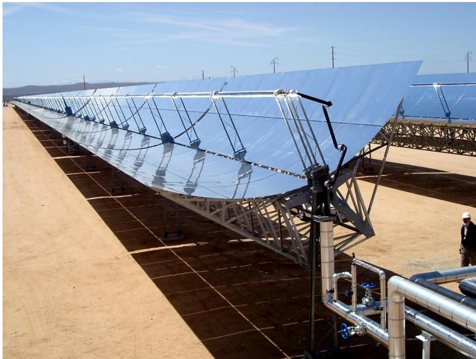
Figura 7 – Concentrador parabólico Fonte: RENEWABLE POWER NEWS (2009)
