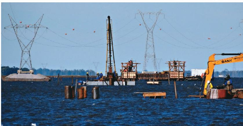
FIGURA 7.6 Construção de linha de transmissão de 525 kV entre Povo Novo e Marmeleiro, em trecho *offshore* sobre a Lagoa Mangueira, em desvio da Reserva do Taim.
