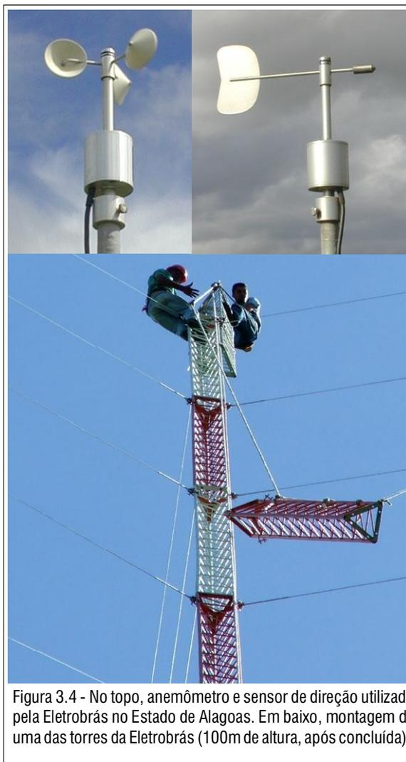
Figura 3.4 - No topo, anemômetro e sensor de direção utilizado pela Eletrobrás no Estado de Alagoas. Em baixo, montagem de uma das torres da Eletrobrás (100m de altura, após concluída).
