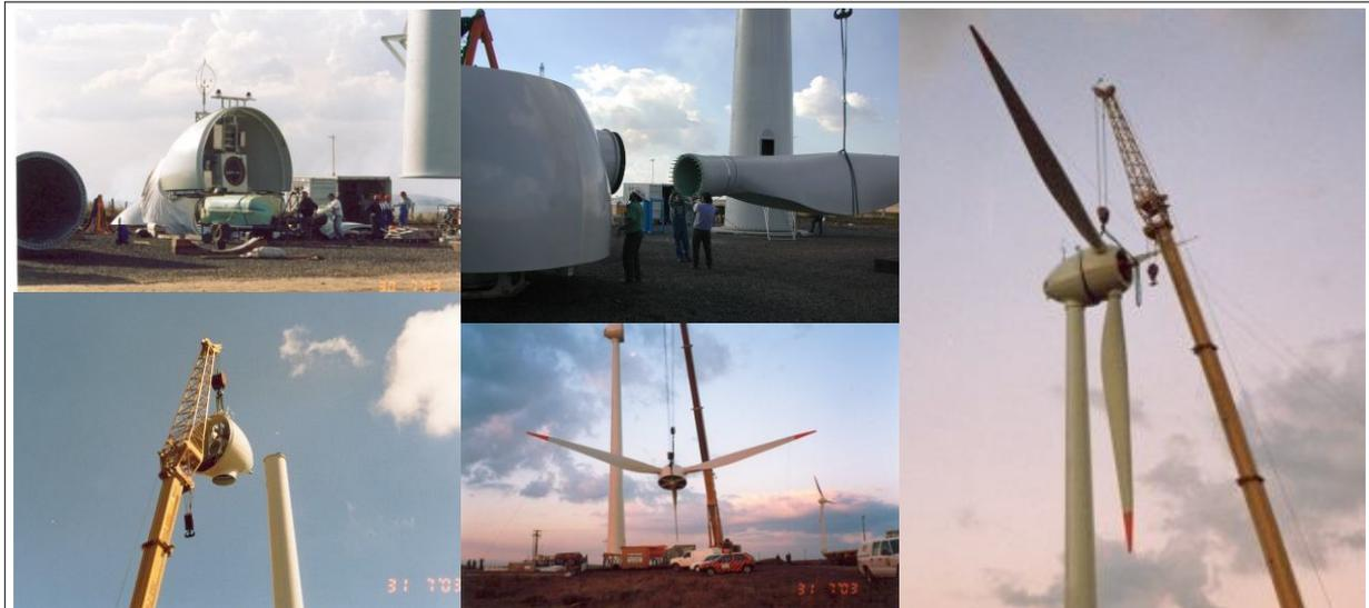
Figura 2.8 - Etapas na montagem de um aerogerador, com detalhes do posicionamento da nacela e do rotor.
