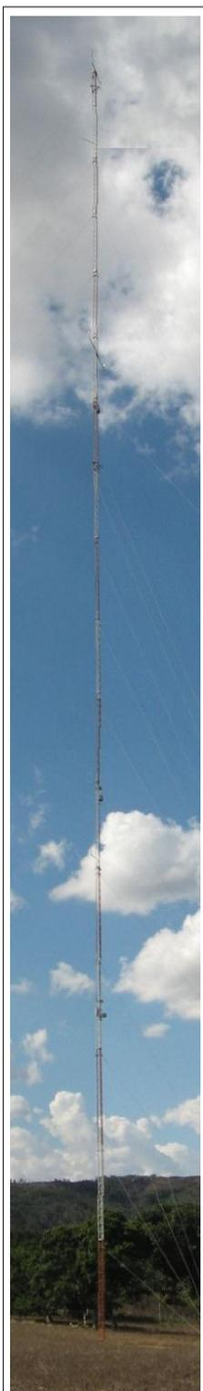
Figura 3.3 - Torre de monitoramento anemométrico de 100m de altura.
