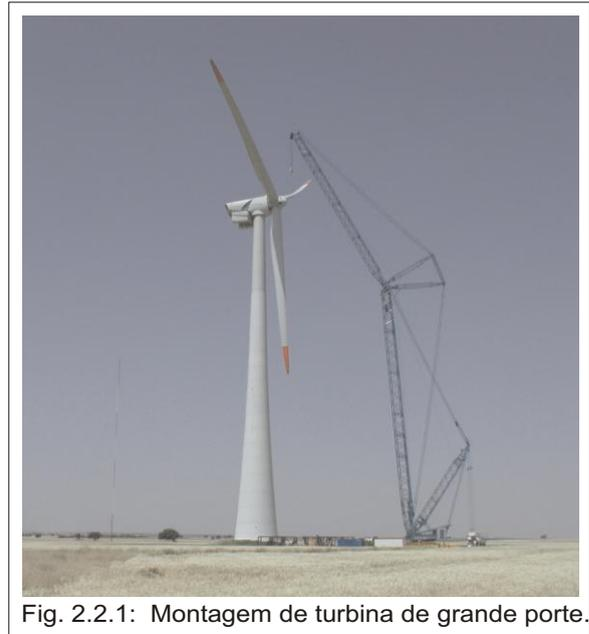
Fig. 2.2.1: Montagem de turbina de grande porte.
