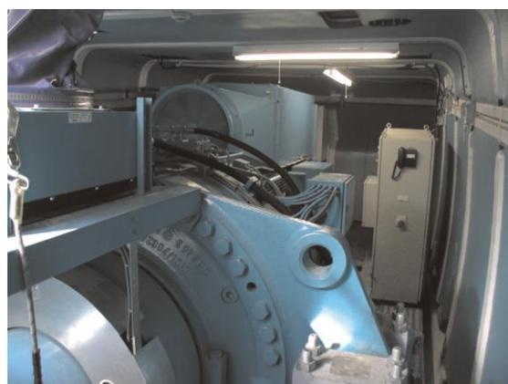
Fig. 2.2.4: Usinas eólicas, detalhes de nacelle, cubo e rotor, e interior da nacelle: caixa de engrenagens, gerador e painéis de controle.
