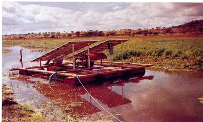
Foto 3 - Sistema de bombeamento para irrigação em Capim Grosso (BA)
